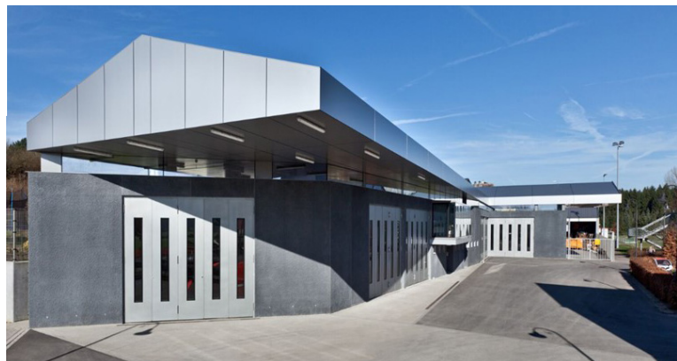
Atelier communal avec poste de pompier à Biver © Steve Troes
